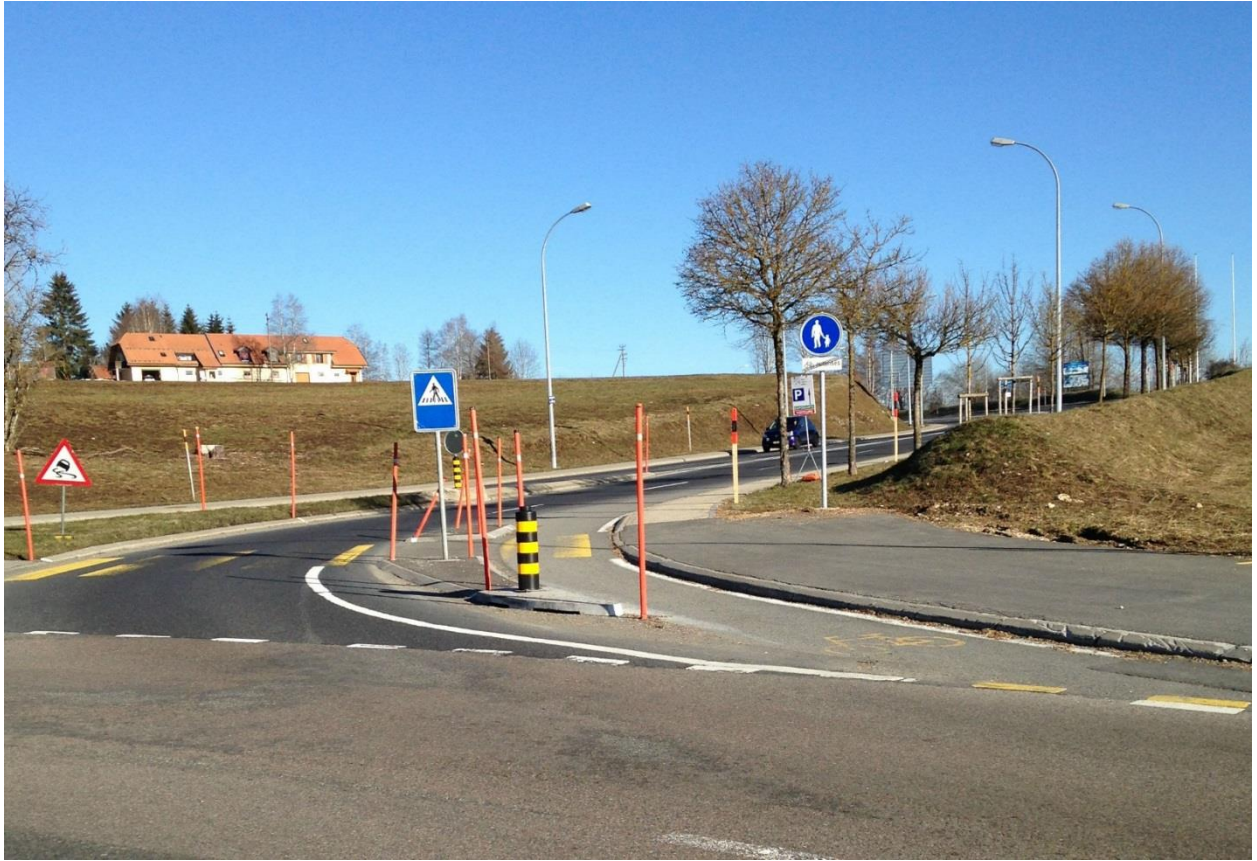
Figure 27 : Le cycliste circule dans le giratoire et y côtoie des véhicules circulant à relativement grande vitesse. A cette sortie, un îlot protège les cyclistes sur quelques mètres mais ils sont ensuite à nouveau mêlés au trafic.
