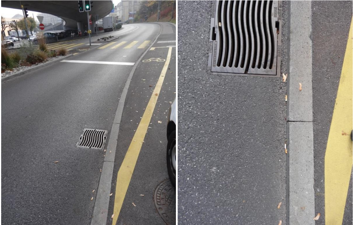
Figure 21 : Le cycliste qui souhaite éviter le giratoire peut s'insérer sur le trottoir et utiliser le poussoir pour traverser en parallèle du passage pour piétons. Cependant, pour aller sur le trottoir il faut franchir une bordure en biseau qui n'est pas affleurée à la route, provoquant d'importants risques de chute.
