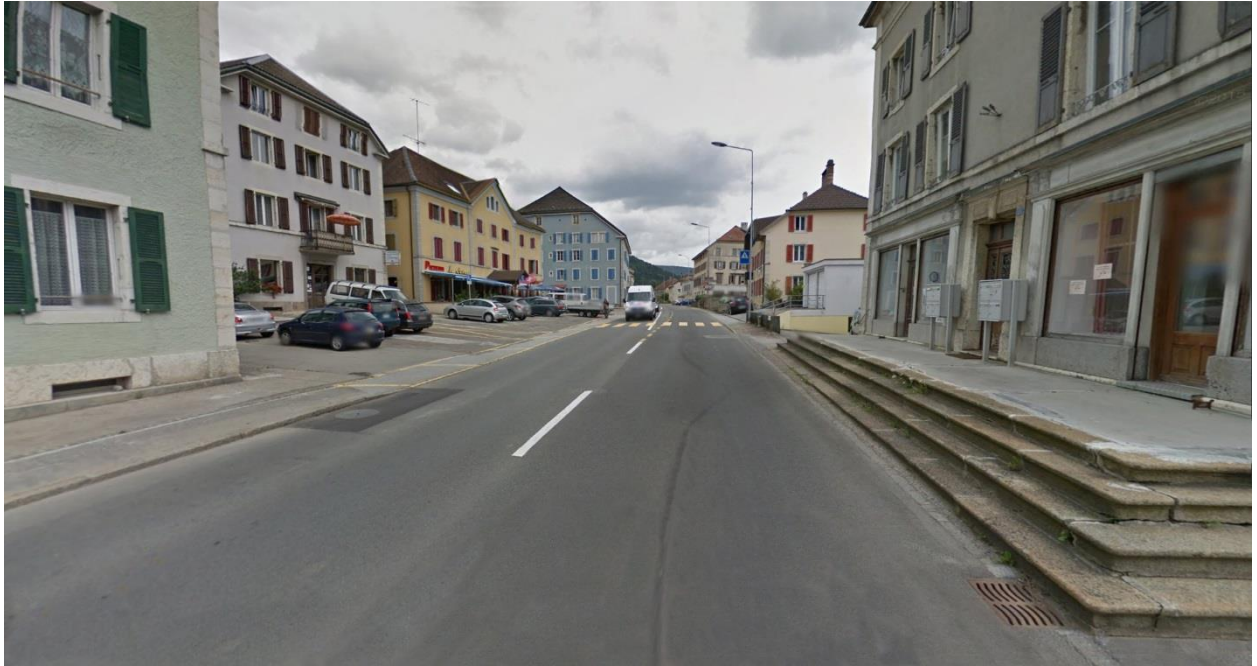
Figure 3 : Vue de la Place de l'Ours avant les travaux. (Source : maps.google.ch)
