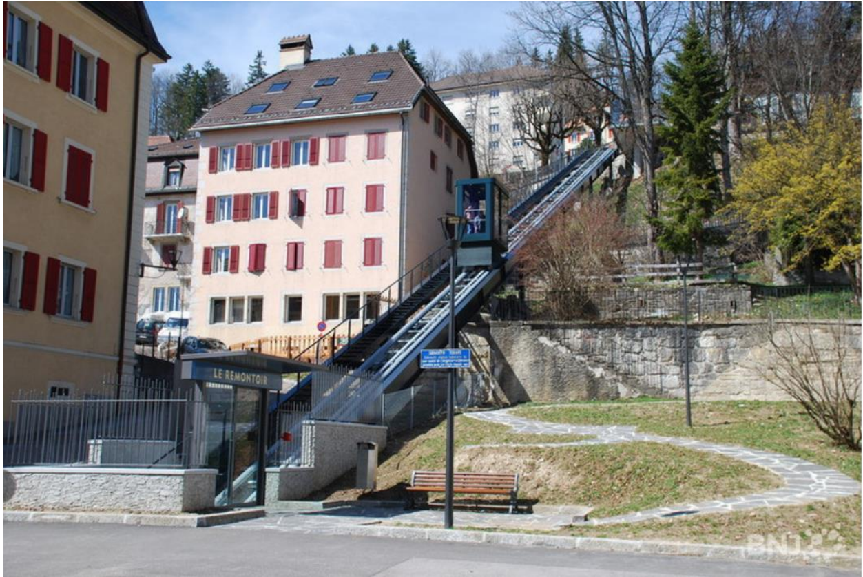
Figure 13 : Vue du Remontoir depuis la Place du 1 er Août. (Source : BNJ).
