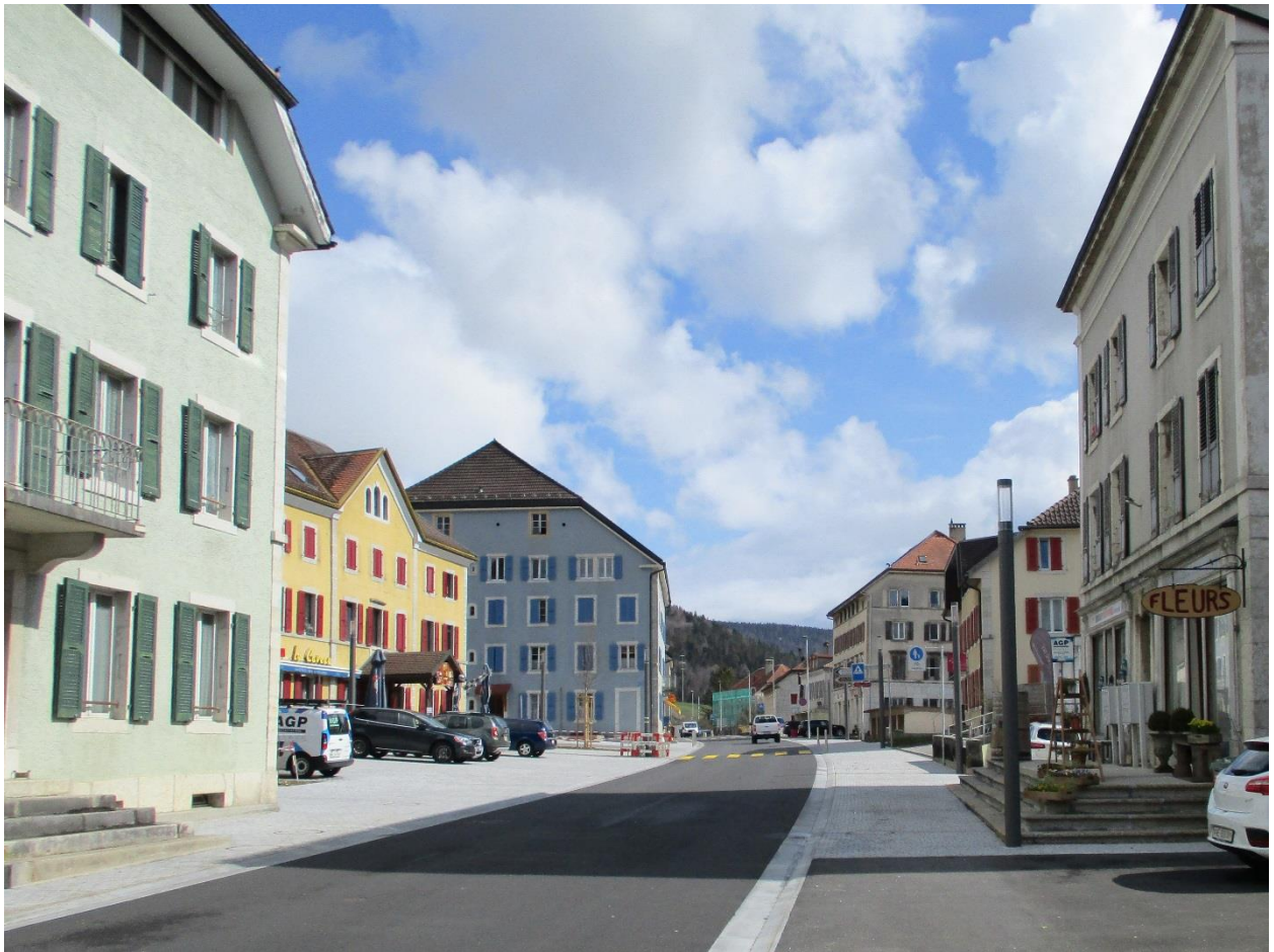
Figure 4 : Vue de la Place de l'Ours après les travaux. (Source : commune de Val-de-Travers).
