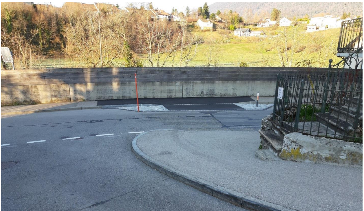
Figure 32 : Vue de l'aménagement depuis la Rue de la Gare.
