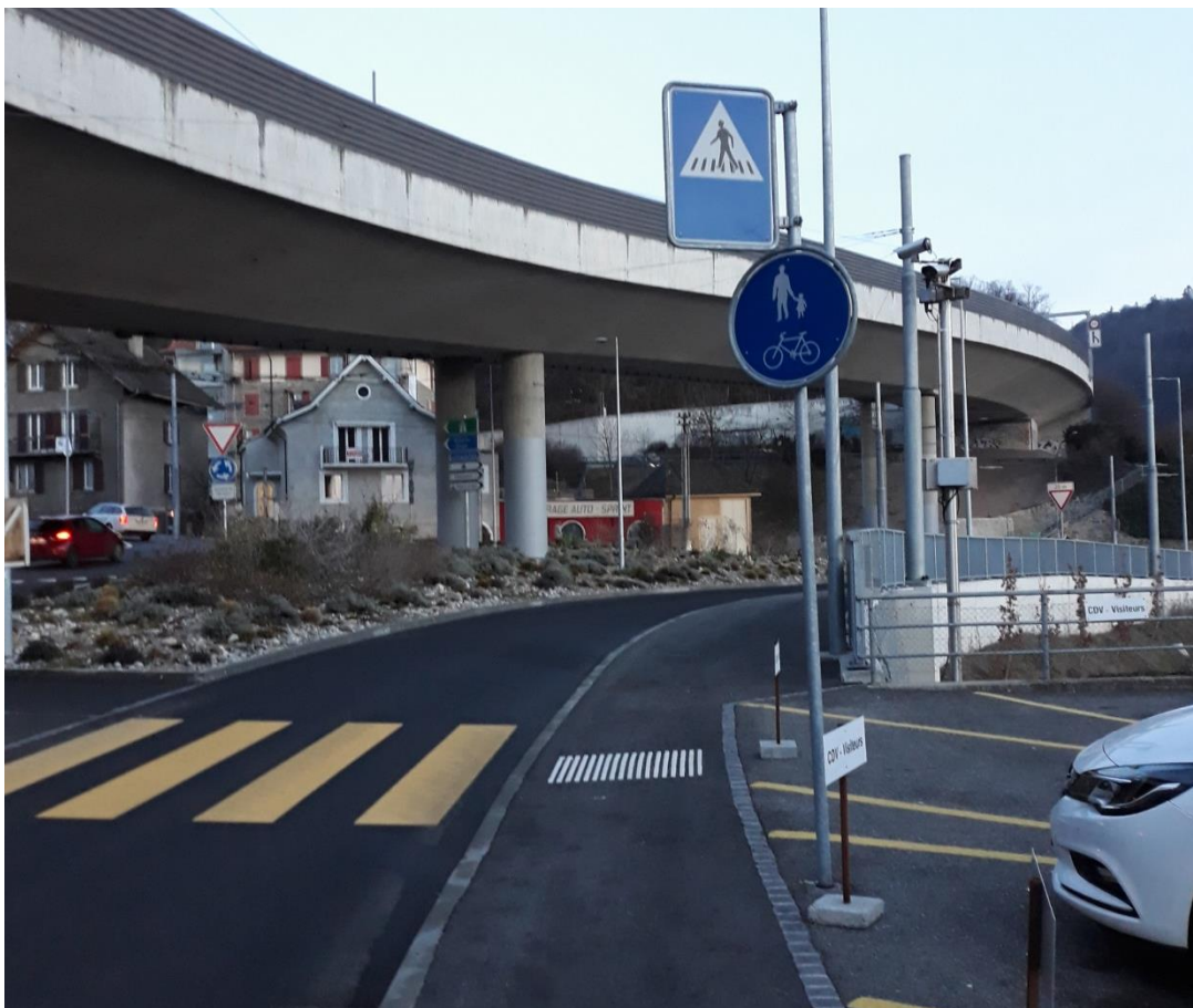
Figure 22 : Le cycliste doit obligatoirement monter sur le trottoir (panneau bleu « piste cyclable ») au droit d'un passage pour piétons, avec les risques de conflit que cela implique. Le cycliste doit se réinsérer dans le trafic quelques mètres plus loin, avec une perte de priorité.
