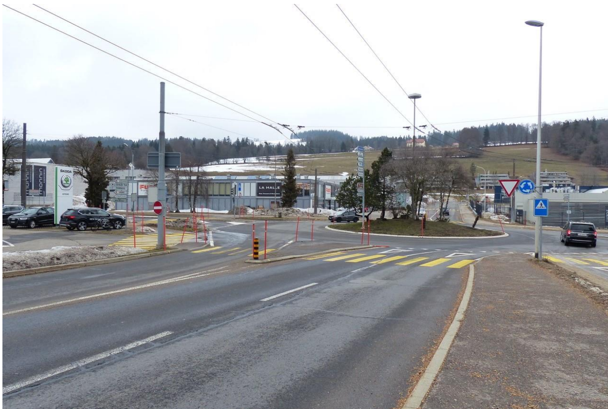
Figure 24 : Arrivée au giratoire depuis le sud. Pour rejoindre la piste cyclable existante située sur la gauche, le cycliste doit d'abord s'engager dans le giratoire.
