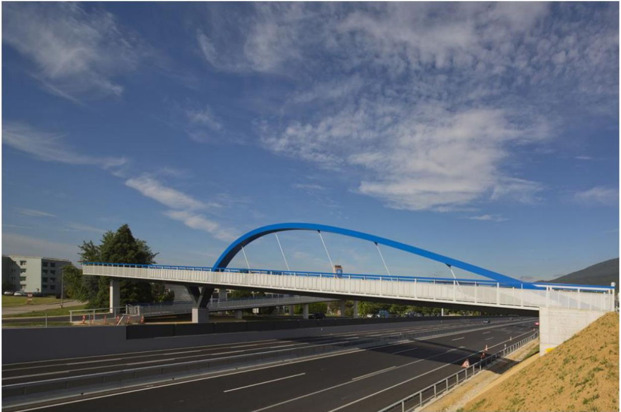
Figure 10 : Passerelle vue depuis l'accès nord. (Source : Sottas.ch).
