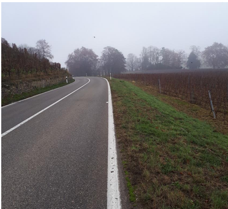
Figure 30 : La chaussée est relativement étroite et la visibilité mauvaise à certains endroits tels que ce virage.
