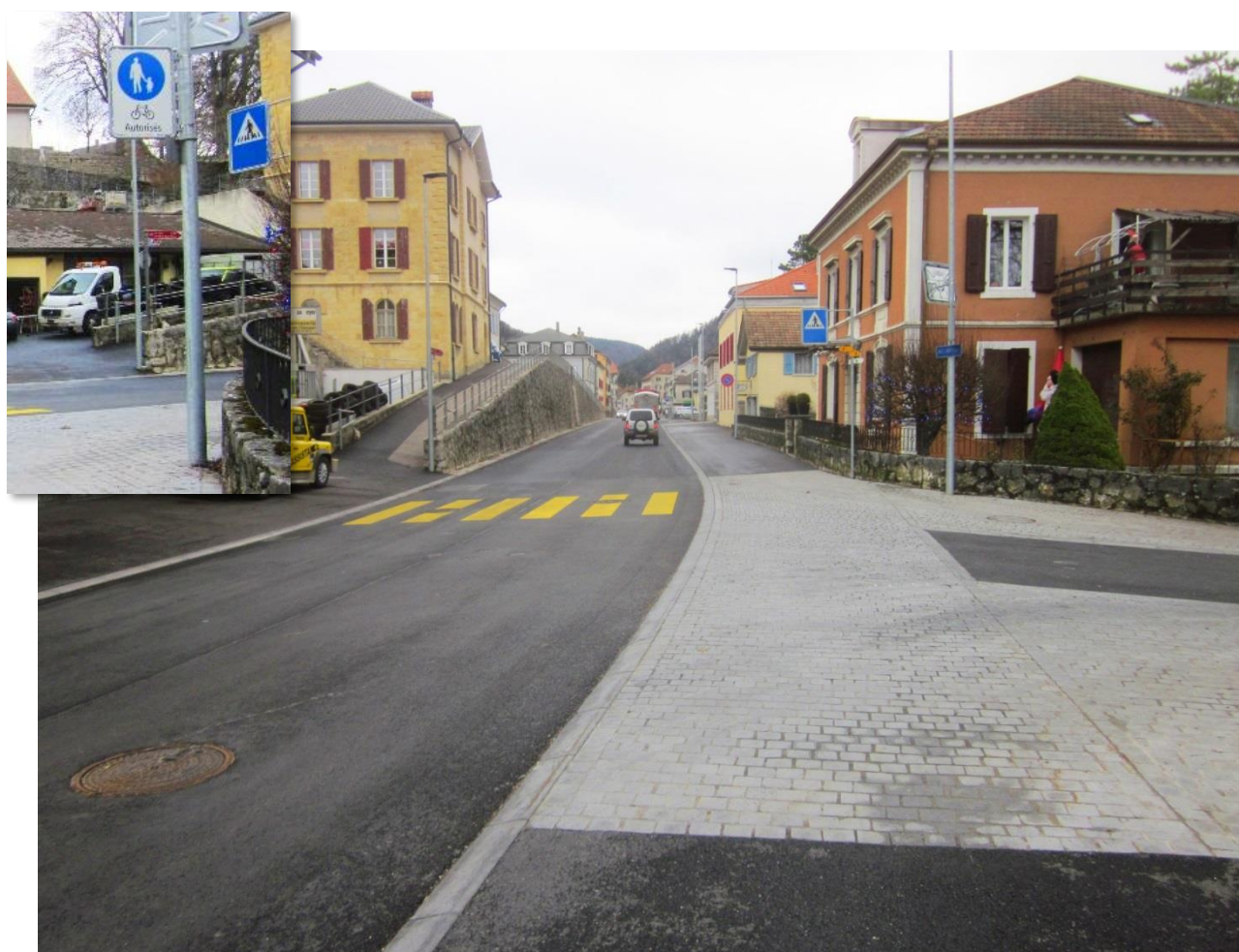
Figure 2 : Vue du trottoir mixte aménagé en trottoir « traversant », qui octroie la priorité aux usagers du trottoir dans le carrefour. (Source : Commune de Val-de-Travers)
