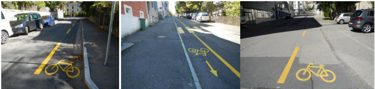
Figure 17 : Marquage de bandes cyclables pour sécuriser les contresens cyclables. (Source : Ville de La Chaux-de-Fonds)
