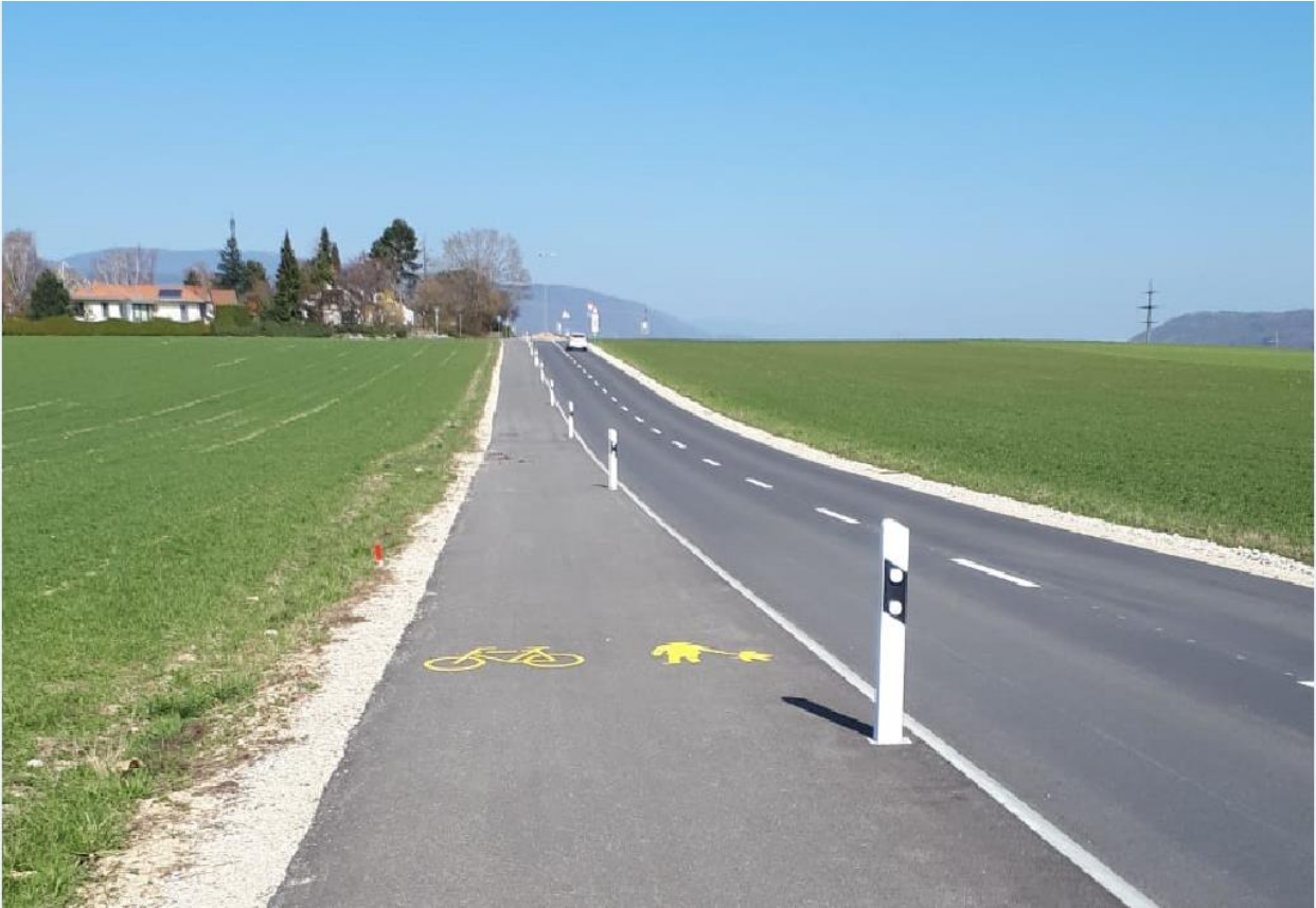
Figure 11 : Trottoir mixte bidirectionnel sécurisé entre la passerelle et Wavre.
